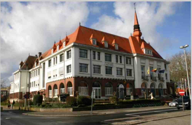
Het Casino van Beringen is een van de 46 openbare gebouwen die gerenoveerd werden. FOTO RV
